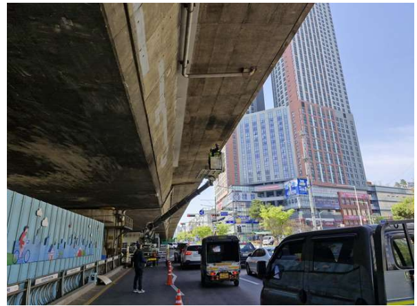
고소점검차를 이용한 현장조사
