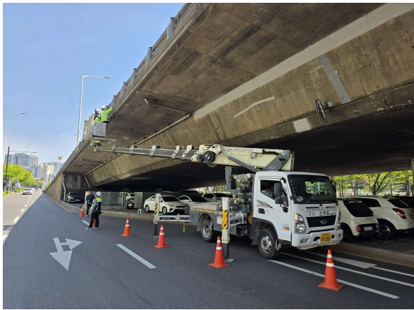
고소점검차를 이용한 현장조사
