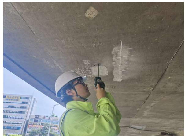
탄산화깊이 측정 현황
