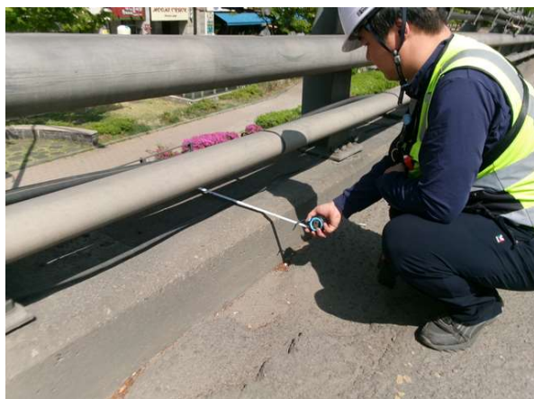
부재치수 현장측정 전경
