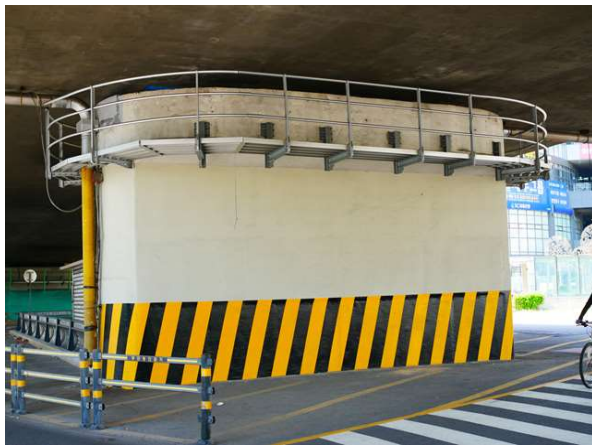
교각 P2 전경
