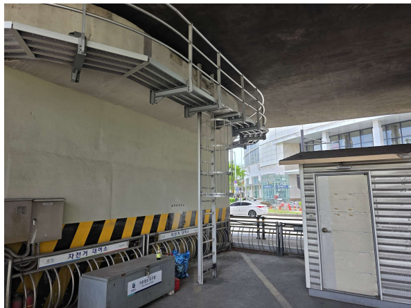
교량 점검시설 전경
