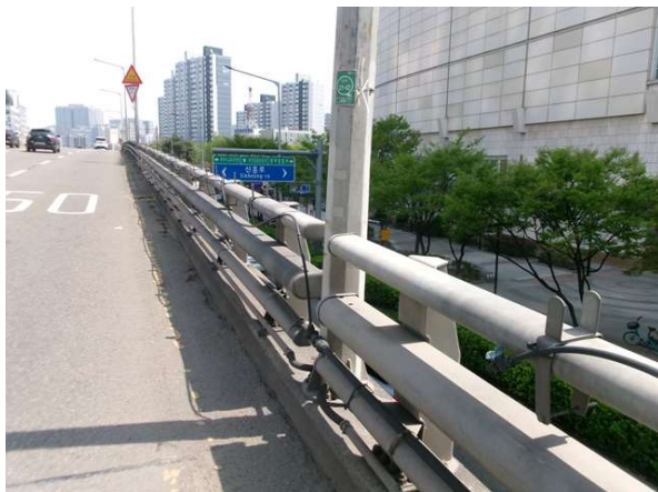
난간 및 연석 전경
